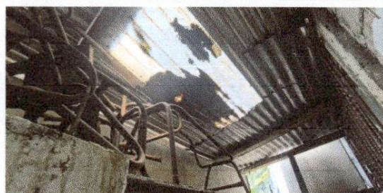
FOTO 1: Sustitución de lámina, por lámina troquelada aluzinc calibre 26 Y Sustitución de estructura de soporte de madera, por metal
