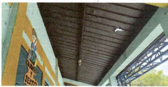
FOTO 6: Mantenimiento a estructura de soporte de metal
