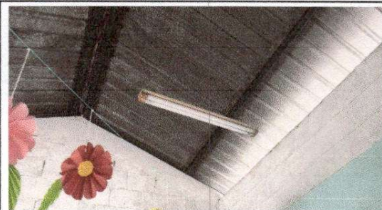
FOTO 8: Instalación de unidades luz (incluye interruptor, ducto y cable eléctrico) Y Instalación de unidades fuerza (tomacorriente), incluye cable eléctrico.
