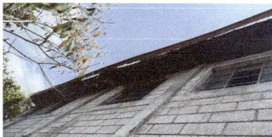
FOTO 7: Sustrución de canal de metal, Sustrución de bajada de agua pluvial de metal por tubo PVC 3" Y Sustrución de soporte o pescante de metal para canal.
