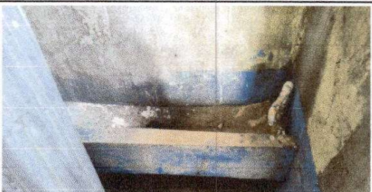
FOTO 4: Sustitución de tubería línea principa
