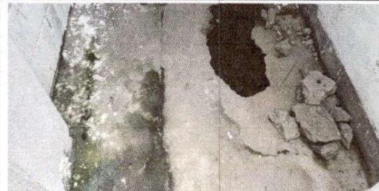
FOTO 2: Sustitución de piso cerámico
