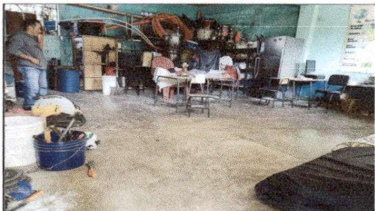
FOTO 9: Sustrución de piso cerámico
